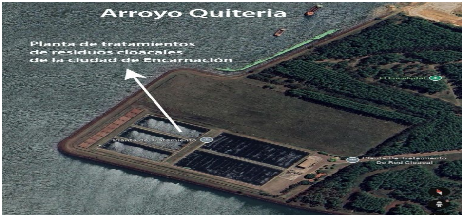
Figuras 43. Vistas de la Planta de Tratamientos de residuos cloacales de Encarnación
