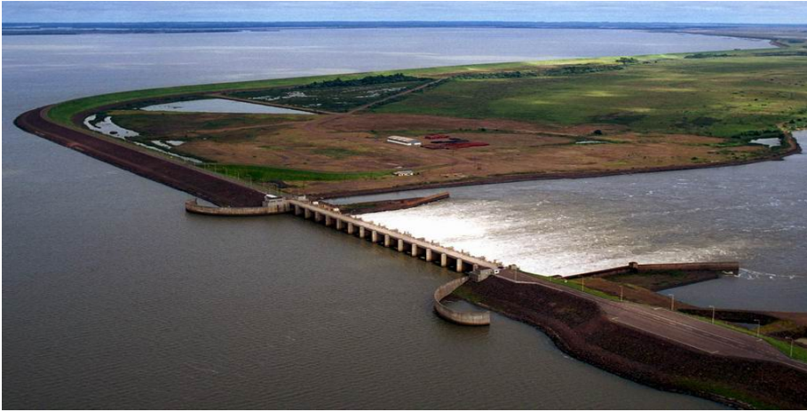
Figura 2: Vista del Vertedero de Yacyretá situado en el Brazo Aña Cuá
