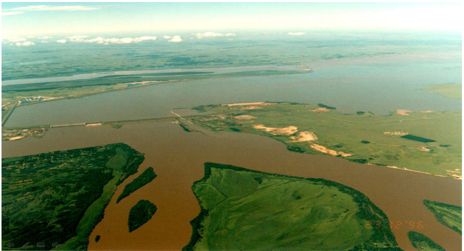
Figura 1: Vista aérea del muro de contención de la Represa de Yacyretá
